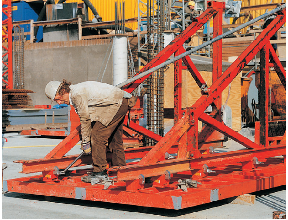
Postavljanje SB rama SB-A, B, C na položeni TRIO element.
