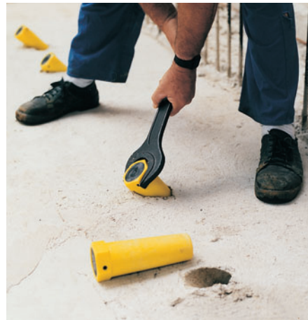
... i jednostavna demontaža konusa nakon betoniranja.
