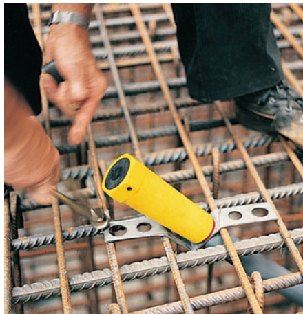
Jednostavno pričvršćivanje ankera na armaturu ...
