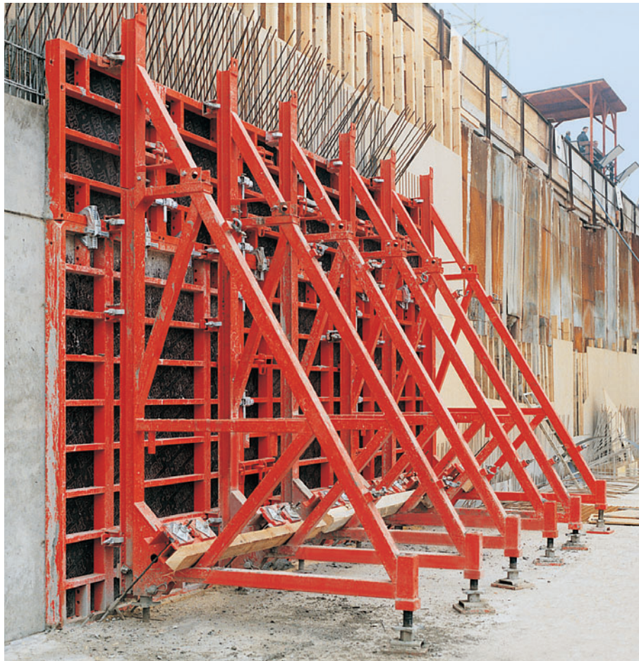
Ramovi SB-B i SB-C u kombinaciji sa zidnom oplatom PERI TRIO, visina betoniranja 3,50 m.
