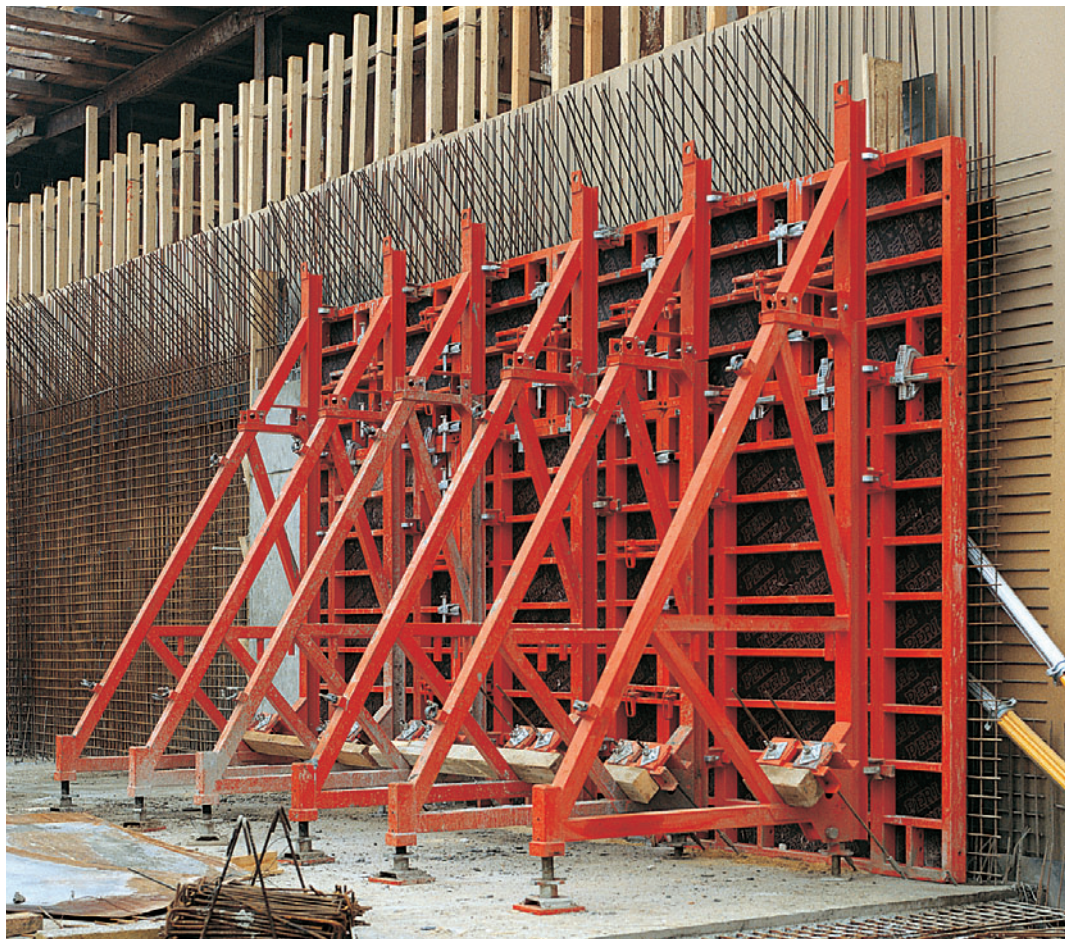
SB-B, C ram i oplata zidova TRIO, visina betoniranja 3,90 m.
