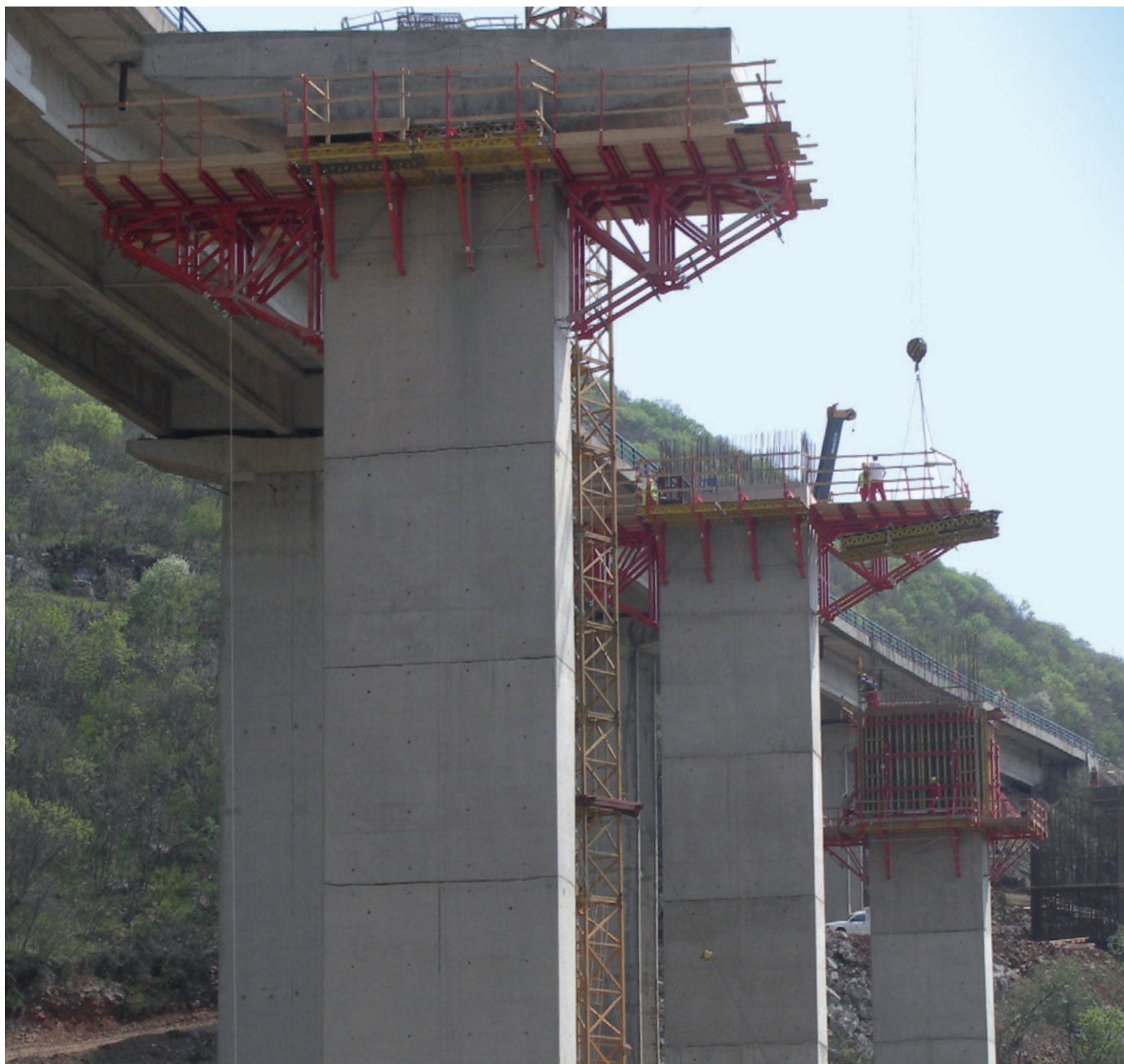
Primena sistema SB-A i B ramova kao radne platforme i konzole za velika opterećenja.
