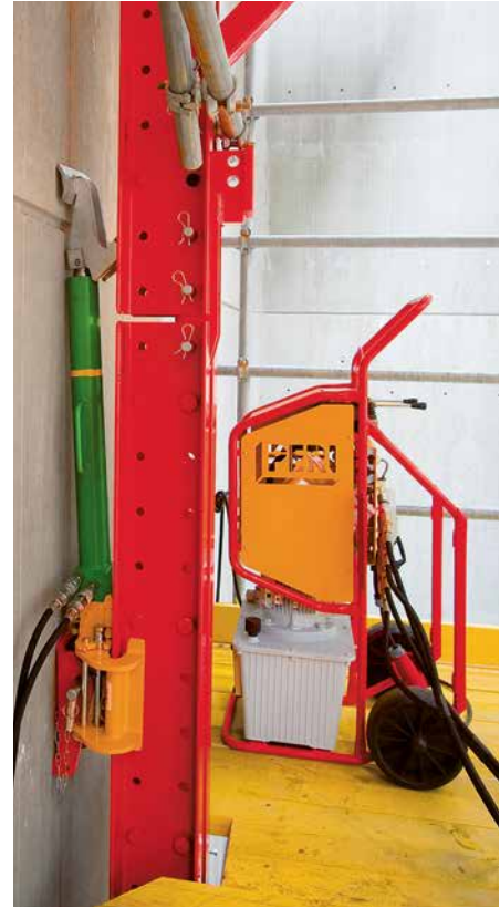
RCS penjajuća šina sa hidrauličnim mehanizmom.
