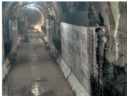
Najbolji rezultati betoniranja drugog takta (područje zidova) osnova su za pokretnu lučnu oplatnu konstrukciju.
