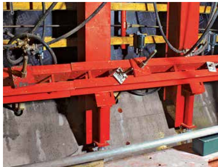
Iskustva sa ankerovanjem SB ramova, mogu se koristiti pri betoniranju drugog takta.
