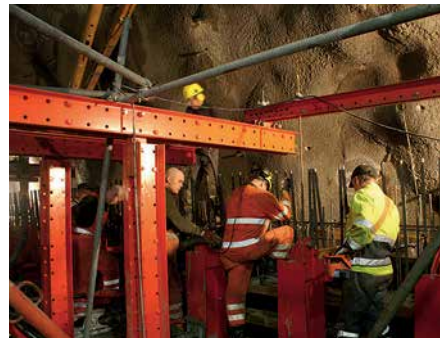
Sistemske elemente za kolica sa oplatom i pokretnu viseću oplatu omogućavaju fleksibilno korišćenje.
