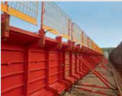
Izrada oplatnih čeličnih kalupa
