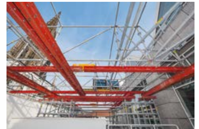
U slučaju ograničenog prostora ili nestabilne podloge, VARIOKIT se može koristiti kao nosiva osnova za različita rešenja PERI UP skela.
