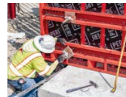
Inovativna tehnika spajanja pomoću X-šrafova i T-ankera omogućava brzu montažu i demontažu oplata.
