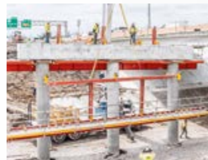
Inovativna Split-Soffit metoda demontaže značajno ubrzava cikluse betoniranja, zbog čega je potrebno manje setova oplata.
