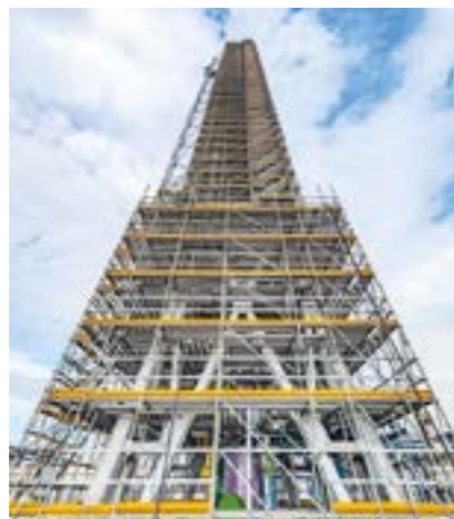
Perforirane antiklektivne patosnice, kontinualna zaštitna ograda, kao i ivične sokle žute boje, garantuju visok stepen zaštite na radu.
