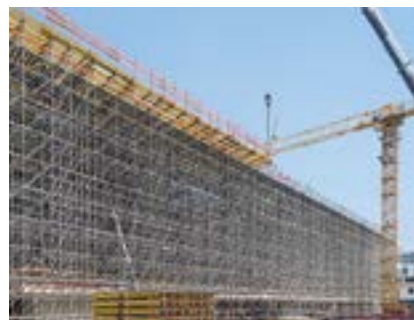
PERI UP tornjevi za podupiranje su kompatibilni sa PERI sistemima za oplatu ploča, a pored toga i usklađeni sa uobičajenim dimenzijama čeličnih i drvenih elemenata.
