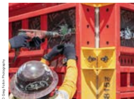
InSite Construction senzor pritiska je još jedna komponenta za ubrzanje procesa betoniranja.
