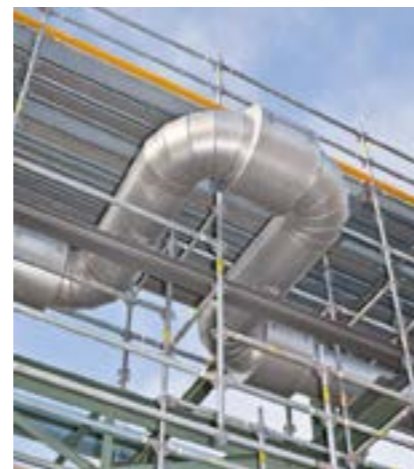
Samoosiguravajući priključak za profil na rozetnu (Gravity Lock) i patosnice sa integrisanim sistemom za zaštitu od podizanja mogu ubrzati proces montaže.
