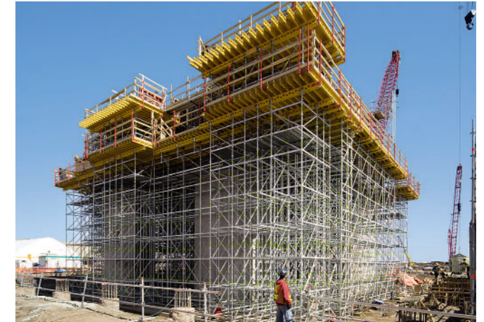
Zahvaljujući upotrebi PERI UP Rosett i MULTIFLEX sistema, omogućeno je bezbedno prenošenje opterećenja masivnih delova građevine, visine između 10 m i 12 m, na osnovu.
