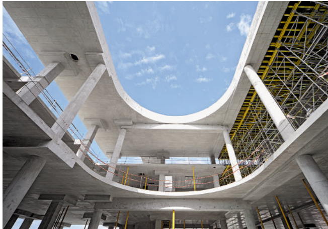
Za izradu armiranobetonske ploče debljine 30 cm korišćen je sistem MULTIFLEX.
