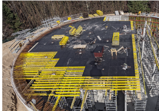
Kao potkonstrukcija dupliranim GT 24 glavnim nosačima korišćena su 82 samostojeća, do 6,50 m visoka, MDS nosiva tornja iz programa PERI UP Flex modularnih skele.
