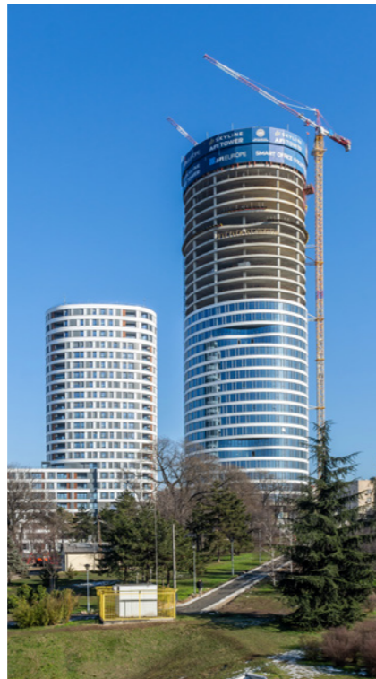
10 Jedno od najviših gradilišta na Balkanu
