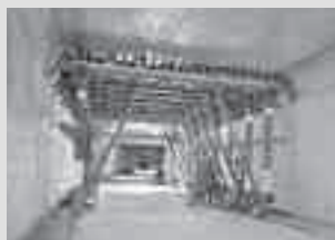
Oplata tunela
