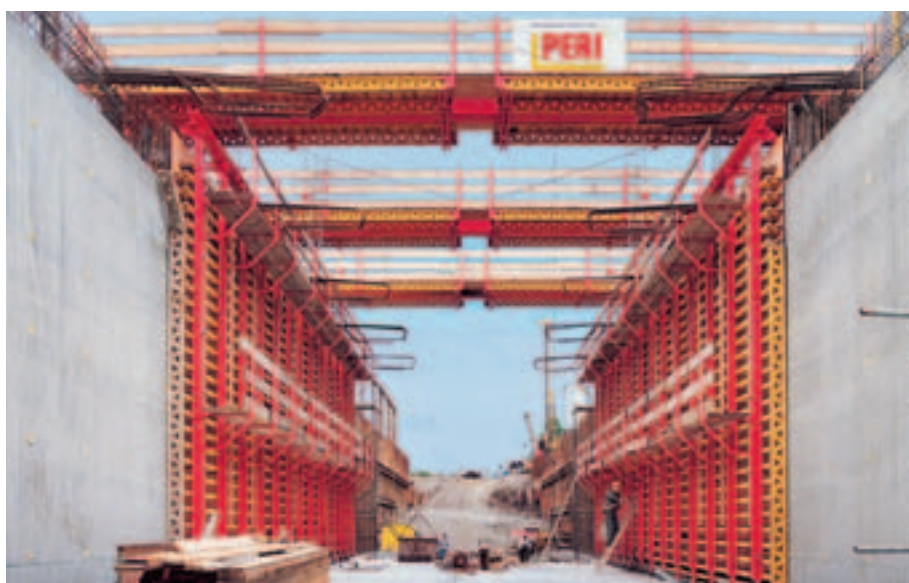
Tunel na obilaznici B 311, Ertingen, Nemačka.
