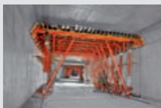
Oplata tunela
