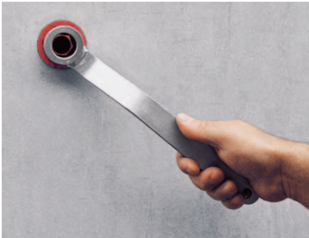
Uklanjanje DK konusa pomoću ključa za konuse DK UNI.
